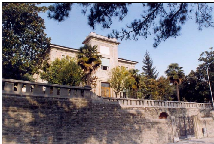
Casa Insieme prima degli ultimi lavori di ristrutturazione
